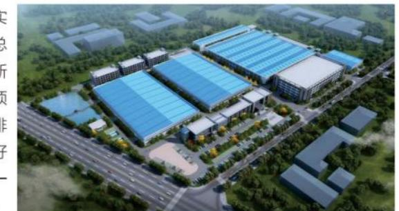
本项目拟建于横山区产业园区，规划占地约85亩，总建筑面积37400平方米，主要建设特种线缆生产车间、原料及成品库、研发办公楼、后勤服务楼、局放试验大厅、实验辅助楼及相关公用辅助设施，完善室外道路、场地硬化、绿化、给排水、电气照明等配套工程。
